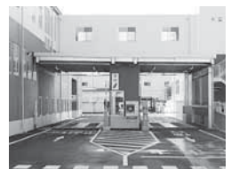
▲計量棟の写真。左側が入口、右側が出口の受付です。
